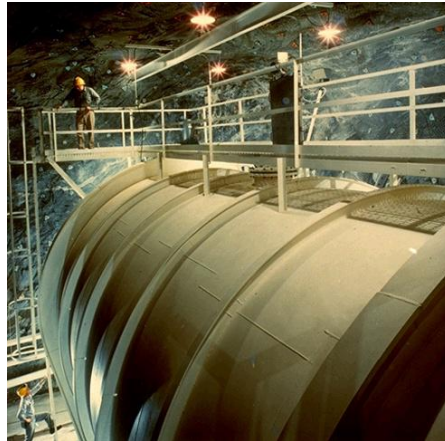
Fig. 3. Detectorul cu tinta de ^{37}\text{Cl} din mina Homestake
